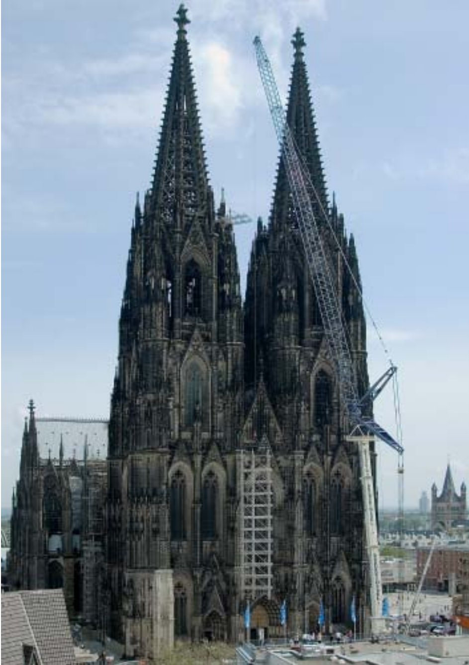
11. Ablassen des Hängegerüsts durch einen Spezialkran am 16. August 2006.
